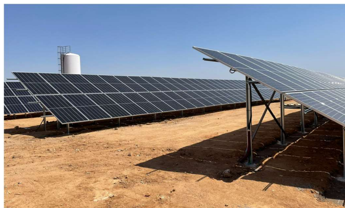
Ejemplo de instalación similar.
